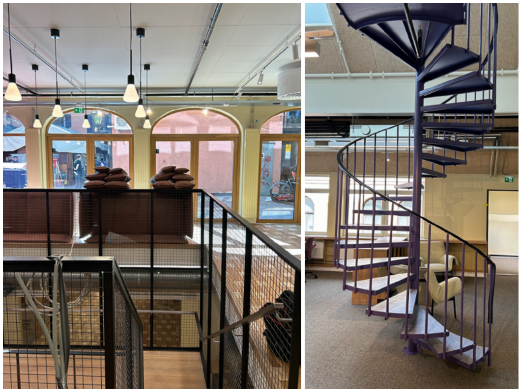
Totalrehabiliteringen av Grensen 9 B har tatt gjenbruk til et nytt nivå: Blant annet er det bygget trapper, gangbaner og reposer i gamle t-baneskinner.
